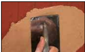
Étape 1 - application directe sur brique plâtrière légèrement humidifiée (pas de sous couche de fond ou d'accroche)
