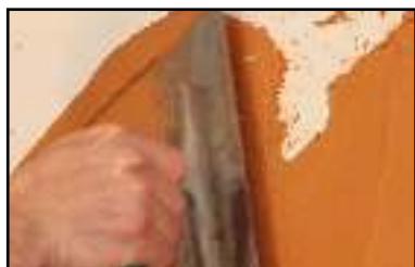
Étape 3 - application de l'enduit en 3mm à l'aide d'une spatule inox.
