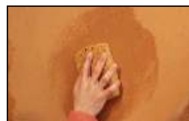
Étape 5 - une fois l'enduit sec, passage d'une éponge semi-humide afin de faire tomber les poussières de surface et faire ressortir le lin.
