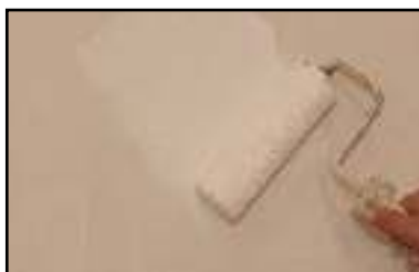
Étape 1 - application au rouleau de la sous-couche d'accroche Argilus.
