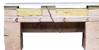
Plancher béton surélevé sur plancher bois
