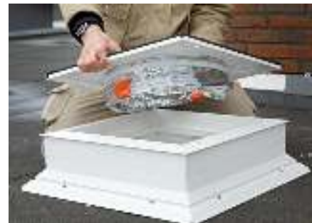
Installation du module extérieur
