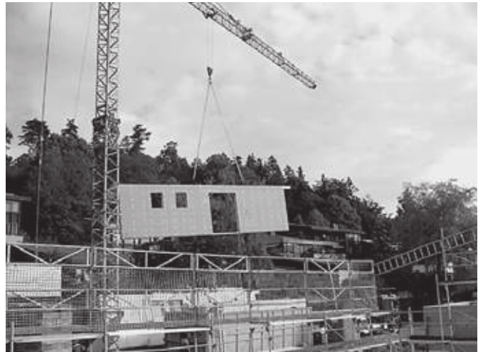
Montage d'éléments ossature bois préfabriqués
