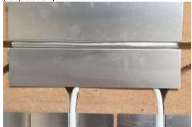
Photo 6.9-2: Recouvrement du retour par un tôle aluminium
