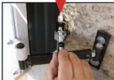
15. Positionner la pièce de raccordement entre l'ancien et le nouveau gond par dessus.
