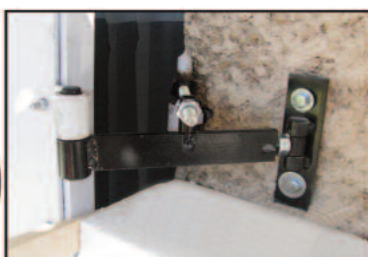
18. Gond I.N.G. ISO mis en place, il ne reste plus qu'à l'isoler.
