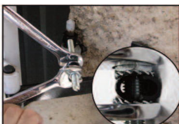
17. Blocage des 2 écrous pour garantir le bon maintien de l'écartement jusqu'à l'ovalisation de la pièce ronde.
