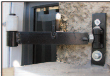
10. Mettre en place la cheville blanche à travers la platine.
