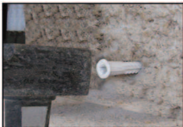
5. Enfoncer la cheville blanche à l'aide d'un marteau.
