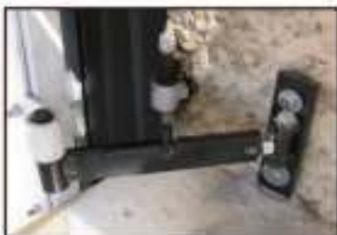
13. Le corps de gond est en place.
