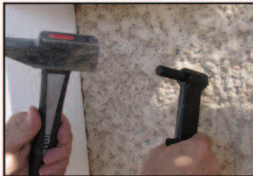
4. Bloquer la clavette dans le corps de gond à l'aide d'un marteau.
