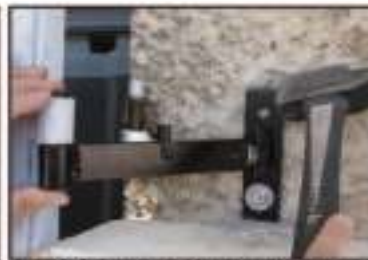
7. Si besoin, grâce au trou plus large, positionner parfaitement le gond.
