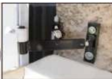
18. Gond I.N.G. ISO mis en place, il ne reste plus qu'à isoler.
