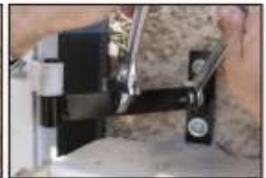
12. Si besoin, redresser le gond en dévissant l'écrou zingué de Ø12 mm et faire bouger le fer plat (clé à molette).
