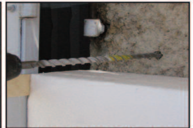
4. Percer un trou Ø10 mm au centre du repère.
