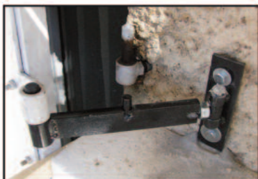
13. Le corps de gond est en place.
