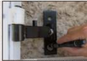
3. Positionner le gond, vérifier qu'il soit bien droit et tracer le trou du bas à l'aide d'un marqueur.
