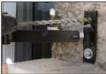
9. Percer Ø10 le trou supérieur à travers la platine.
