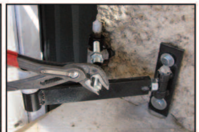
16. Serrer la tige filetée sur l'ancien gond à l'aide d'une pince.
