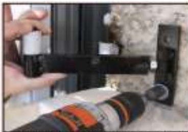
6. Visser le tire-fond avec la grosse rondelle (douille de 13) jusqu'à ce que le gond soit maintenu.
