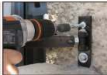
11. Visser le 2ème tire-fond avec la petite rondelle et serrer à fond.
