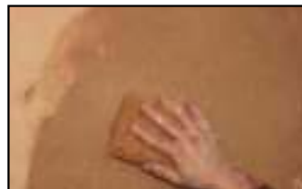
Etape 4 - une fois l'enduit sec, passage d'une éponge semi-humide afin de faire tomber les poussières de surface et faire ressortir le lin.
