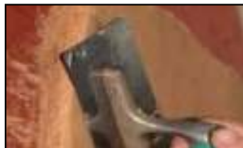
Etape 2 - application à la spatule inox ou à la machine à projeter, sur 1cm d'épaisseur.
