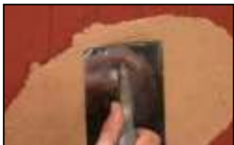
Etape 1 - application directe sur brique plâtrière légèrement humidifiée (pas de sous couche de fond ou d'accroche)
