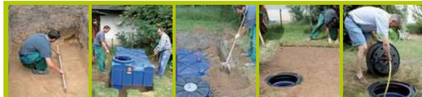
Rappel : le déblai d'excavation ne convient pas au remplissage dans la grande majorité des cas. Se conformer à la notice.
