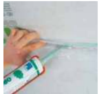
Raccord du freine-vapeur à une cheminée enduite avec pro clima ORCON F.
