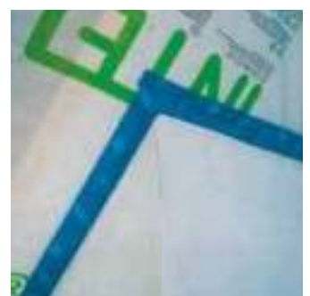
Raccord du freine-vapeur à une cheminée en éléments de montage lisse, non poreuse et non friable avec pro clima TESCON PROFIL.
