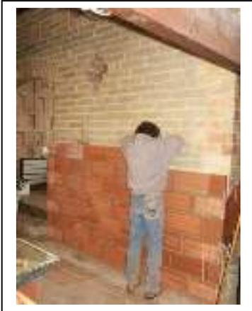
Assembler les briques avec un mortier chaux, plâtre ou colle à brique.
