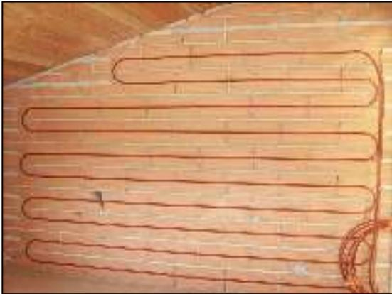
Le type de tube préconisé est un tube en polyéthylène réticulé (PER),  $\varnothing=16$  mm.
