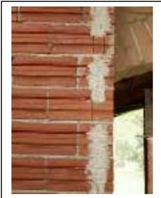
Avec un mortier à la chaux, combler les rainures du passage de la tuyauterie et les réservations de bord de mur en recouvrant les coudes du tube.
