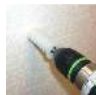
Cheville polystyrène - vue en situation
