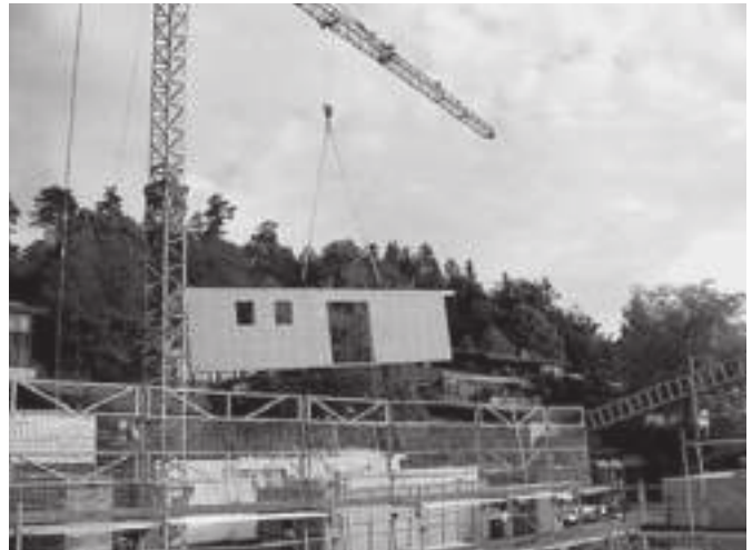
Montage d'éléments ossature bois préfabriqués
