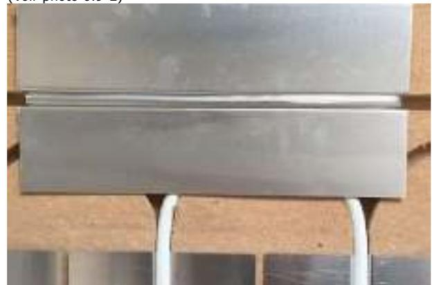
Photo 6.9-2: Recouvrement du retour par un tôle aluminium
